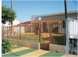
COPEL - Companhia Paranaense de Energia Localização: Rua Pedro Álvares Cabral, entre as ruas Sinop e Gillio Furlaneto
