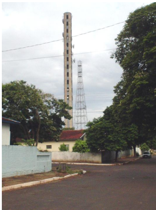
Fig. 6.5.1 - Torre de telefonia localizada na área central de Iporã
