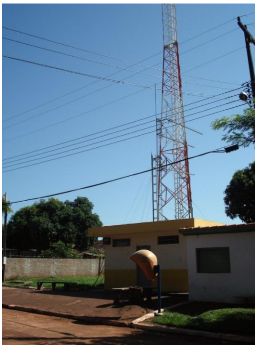
Fig. 6.5.3 - Torre de telefonia Brasil Telecom localizada em Nova Santa Helena
