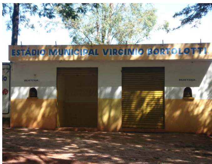
Fig. 6.8.5.1 - Entrada do Estádio Municipal Virgínio Bortolotti
