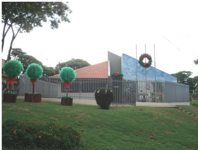
Fig. 6.8.4.2 - Vista da Biblioteca Municipal
