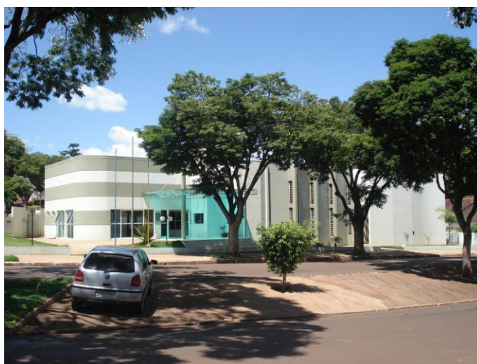
Fig. 6.8.4.1 - Vista do Centro Cultural
