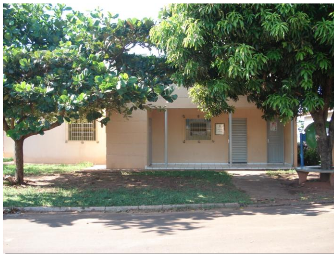
Fig. 6.8.1.4 - Vista da Unidade de Saúde Alto da Sanbra
