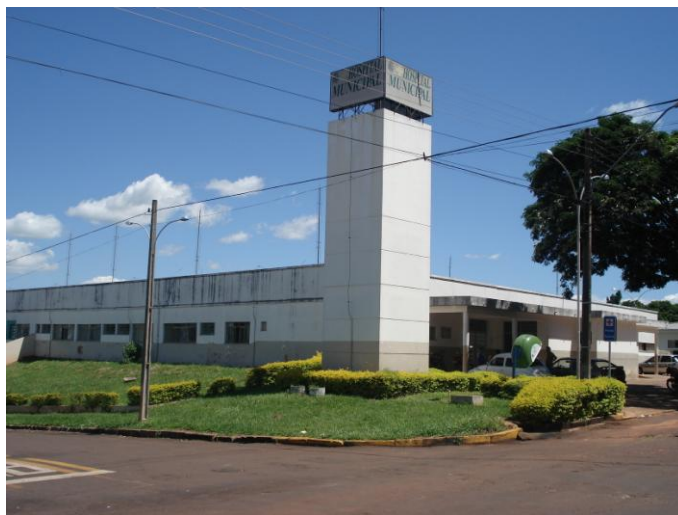
Fig. 6.8.1.1 - Vista do Hospital e Maternidade Municipal
