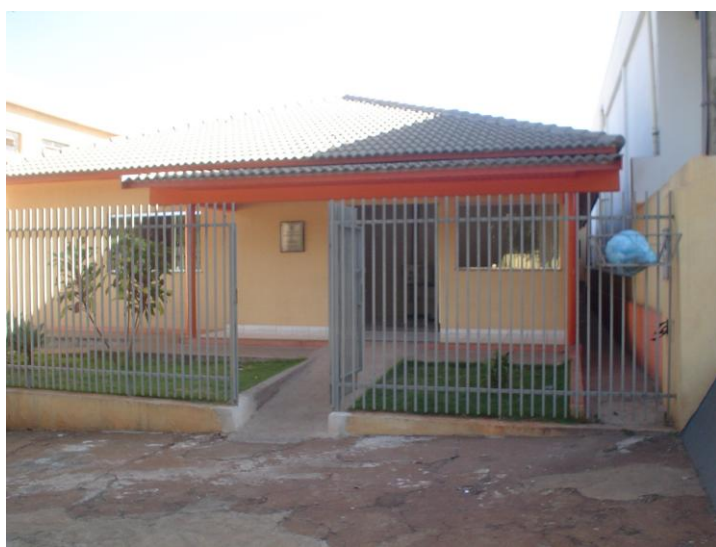
Fig. 6.8.1.7 - Vista do Centro de Especialidades
