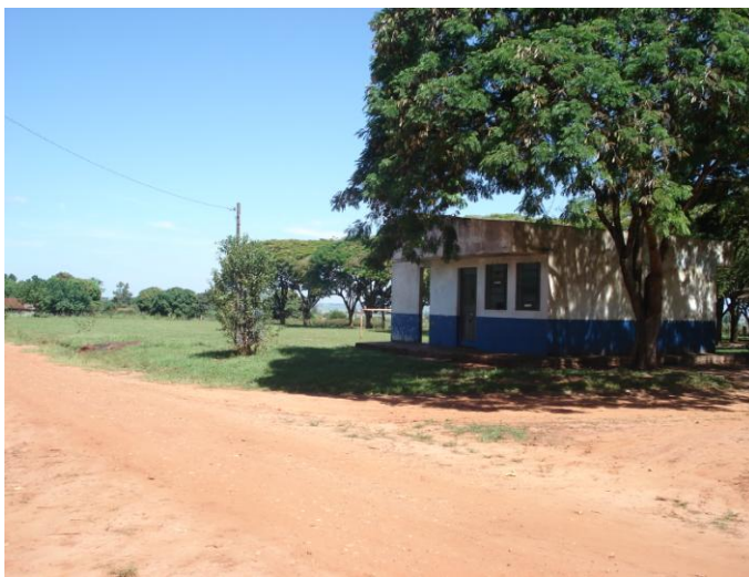
Fig. 6.9.9 – Vista da Construção adaptada para o uso de Capela Mortuária
