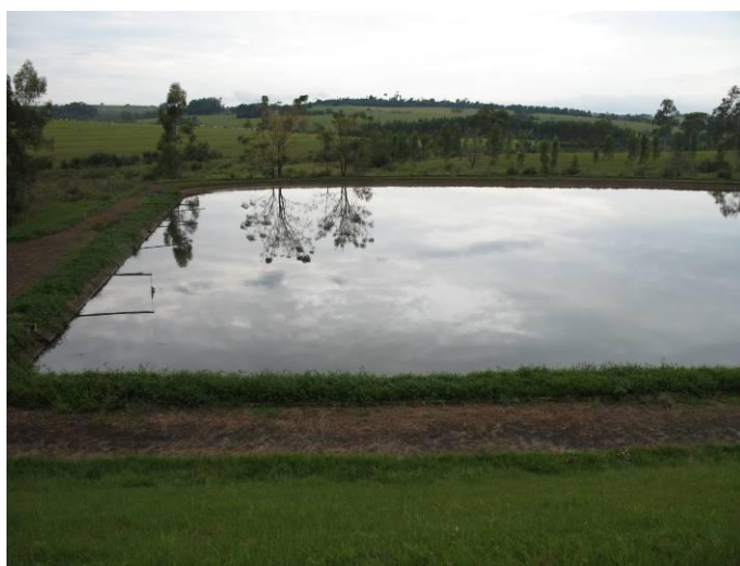
Fig. 6.1.2.1 – Lagoa de tratamento de esgoto do município de Iporã
