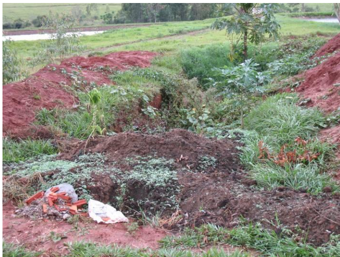
Fig. 6.1.2.3 – Leitos de secagem da ETE de Iporã
