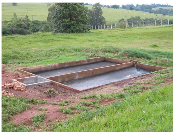
Fig. 6.1.2.2 – Vala para aterramento do lodo
