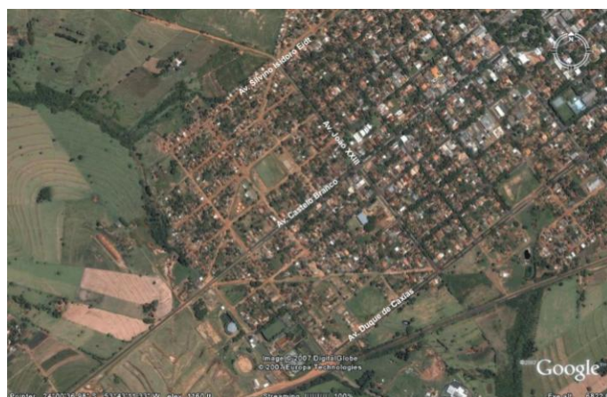
Fig. 6.2.7 – Vias periféricas sem pavimentação Fonte: GoogleEarth
