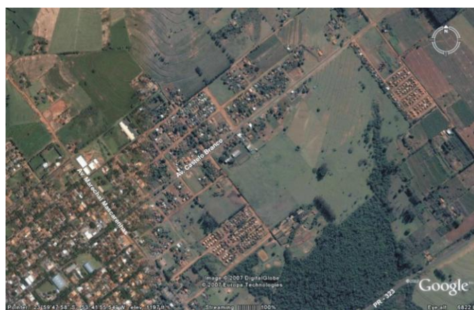
Fig. 6.2.9 – Vias periféricas sem pavimentação Fonte: GoogleEarth
