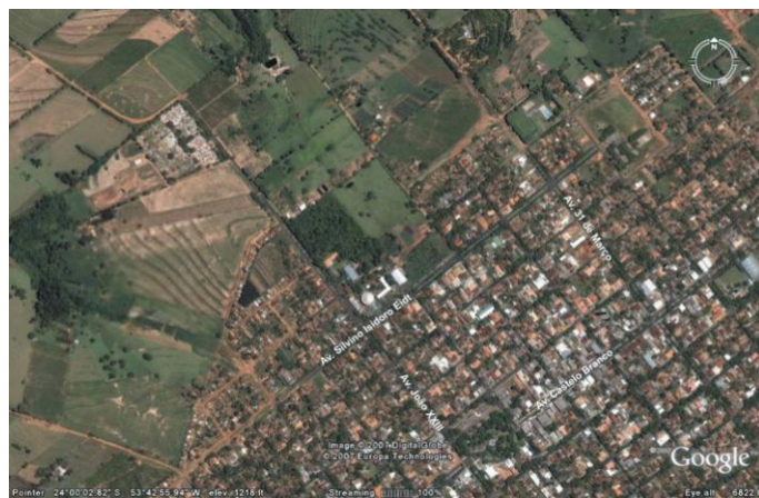
Fig. 6.2.8 – Vias periféricas sem pavimentação Fonte: GoogleEarth
