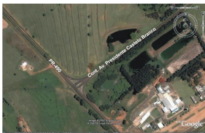
Fig. 6.2.1 – Acesso da rodovia PR-490 a Avenida Presidente Castelo Branco Fonte: GoogleEarth
