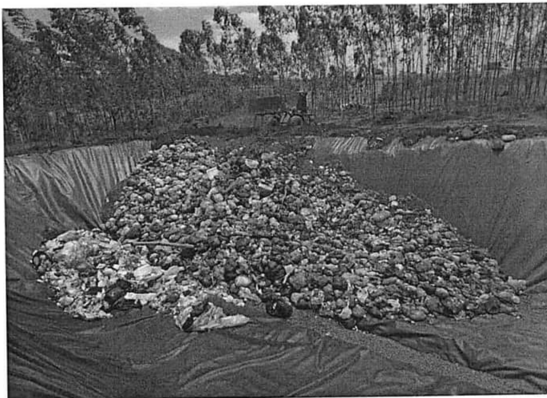
vala do aterro sanitário do município
