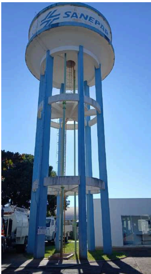
Figura 17 : Reservatório elevado de 100m³.
