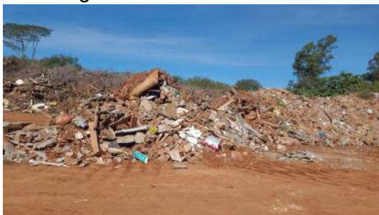
Figura 66 : Entulhos e RCC.
