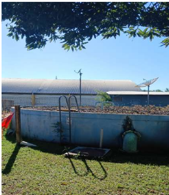
Figura 19 : Reservatório semi enterrado de 600 m³.
