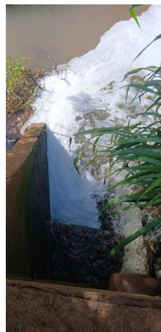
Figura 40 : Ponto de lançamento do esgoto tratado.
