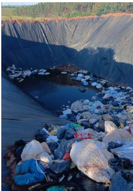
Figura 53 : Vista da vala protegida com manta.
