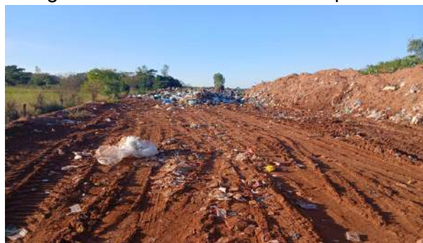
Figura 52 : Vista do aterro municipal.
