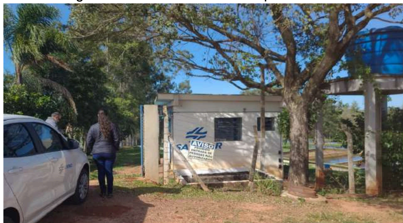
Figura 16 : Entrada da ETA de Iporã/PR.
