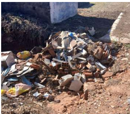
Figura 68 : RCC acumulado em área urbana.
