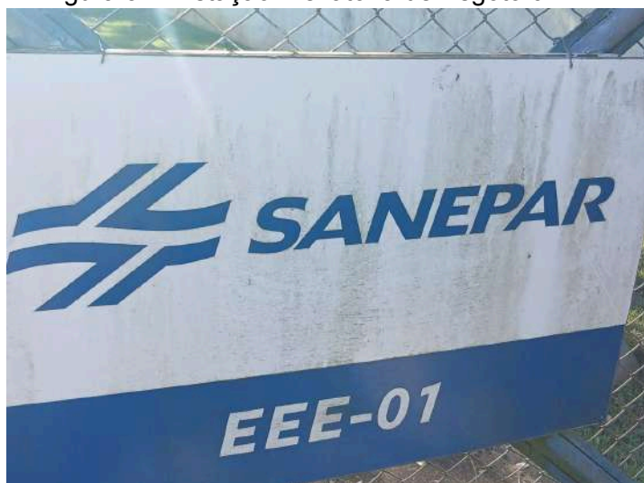
Figura 31 : Estação Elevatória de Esgoto 01.
