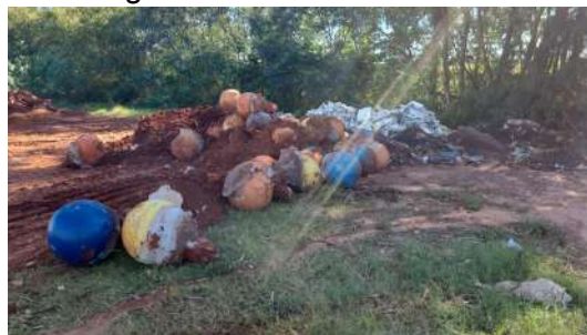
Figura 67 : Acumulado de RCC.
