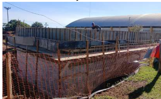
Figura 20 : Reservatório semi enterrado em construção de 500 m³.
