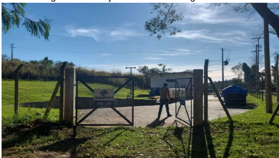
Figura 32 : Estação Elevatória de Esgoto 02.
