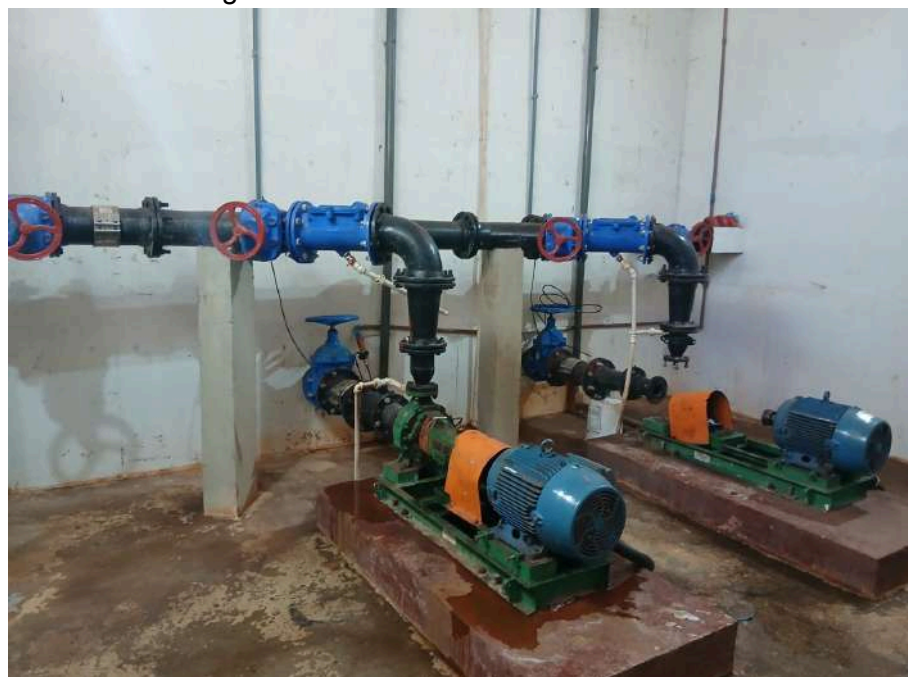
Figura 22 : Casa de bombas da ETA.
