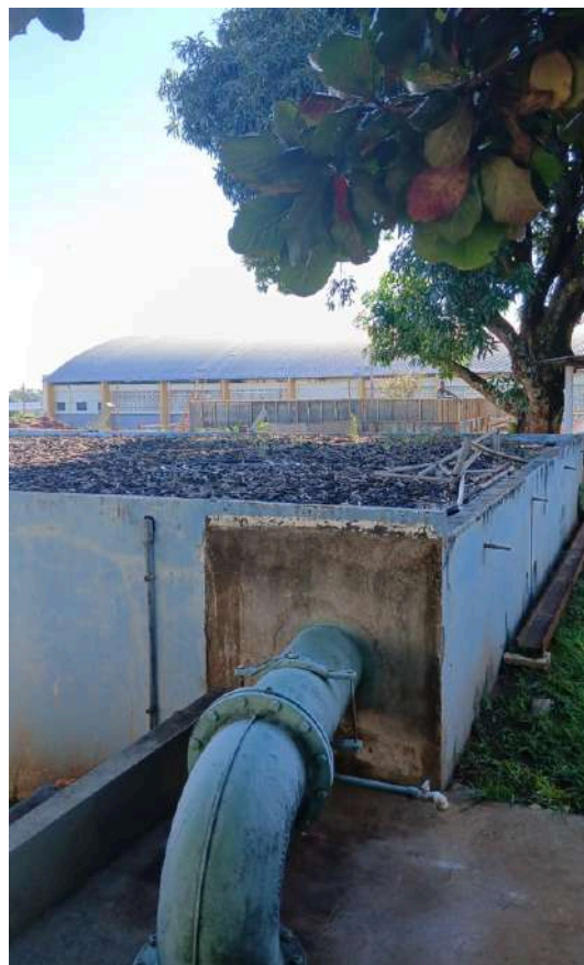
Figura 18 : Reservatório semi enterrado de 300 m³.
